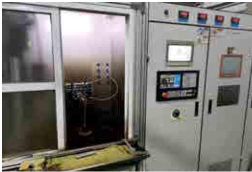
热处理中心 HEAT TREATMENT CENTER
